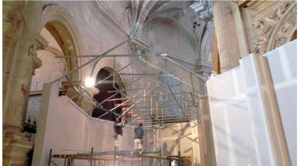
Figura 6. Cerramiento provisional de la girola de la Ex Colegiata de San Patricio, para recuperar el culto en la Capilla del Alcázar mientras se desarrollan en el resto del Templo los trabajos de restauración.
