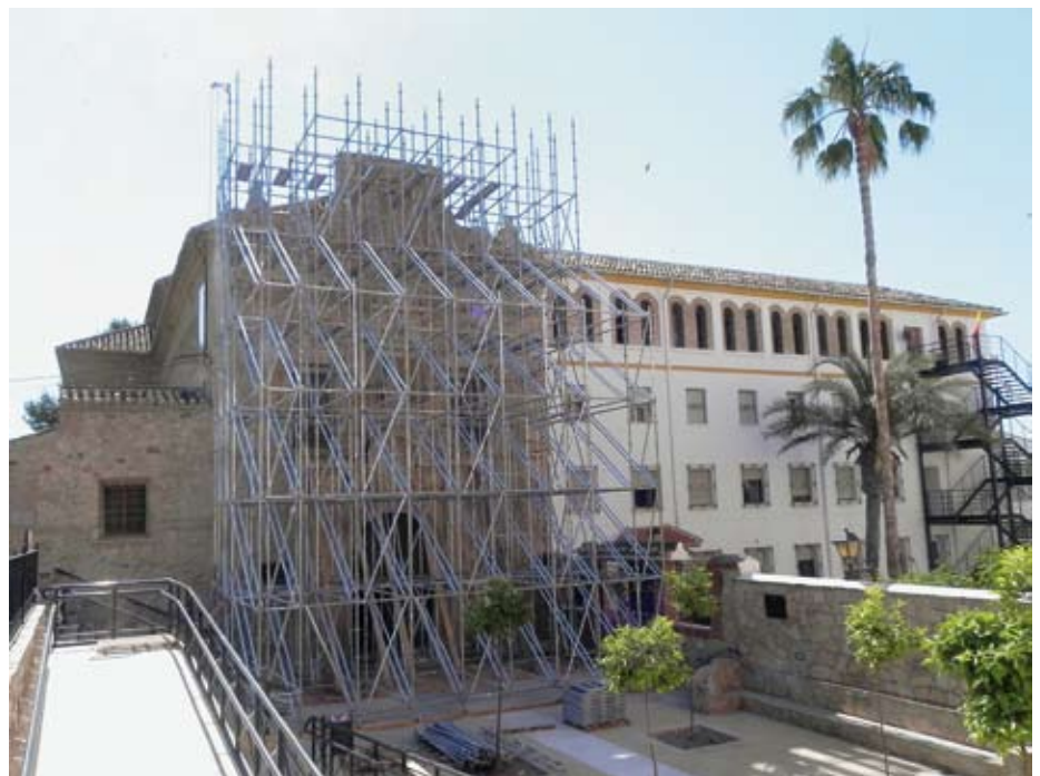
Figura 12. Andamio metálico para apelar la fachada de la Iglesia de San Diego y evitar su vuelco.
