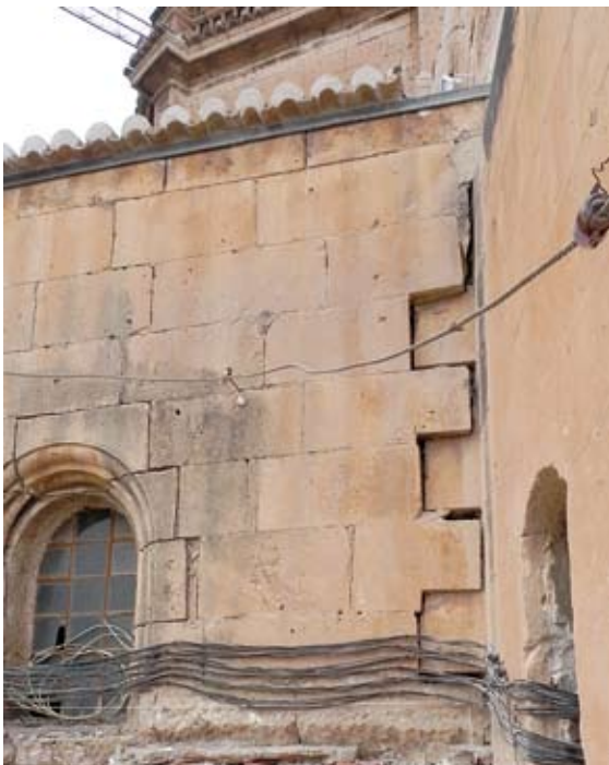
Figuras 8 y 9. Detalles de los engatillados en los sillares de la fachada Sur de la Colegiata de San Patricio, en el encuentro de ellos con la fachada principal, así como en la girola.
