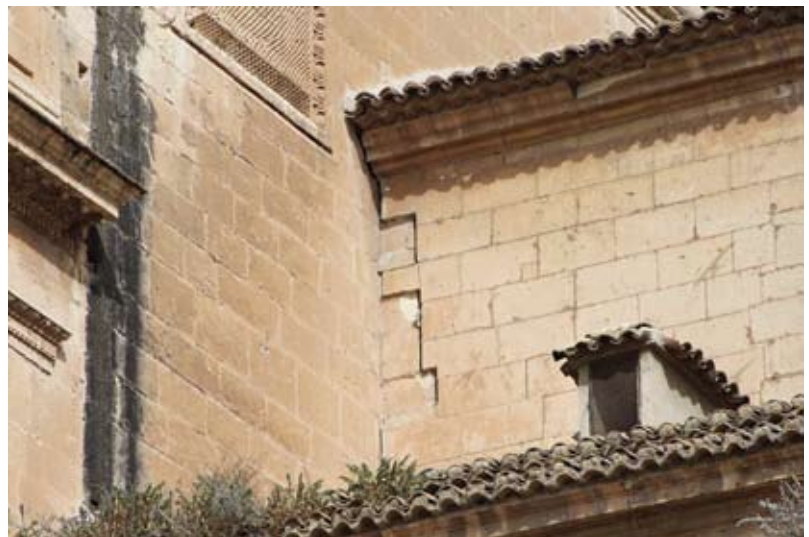
Figuras 8 y 9. Detalles de los engatillados en los sillares de la fachada Sur de la Colegiata de San Patricio, en el encuentro de ellos con la fachada principal, así como en la girola.
