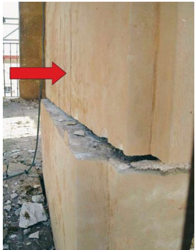
Figura 18. Desplazamiento horizontal del cuerpo de campanas de la Iglesia de San Mateo.
