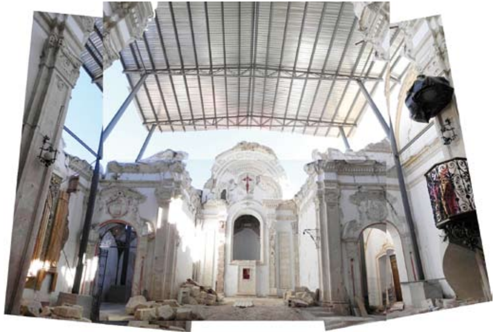
Figura 4. Iglesia de Santiago en Lorca, cubierta con una estructura metálica para protegerla de la intemperie mientras se llevan a cabo los trabajos para su restauración.
