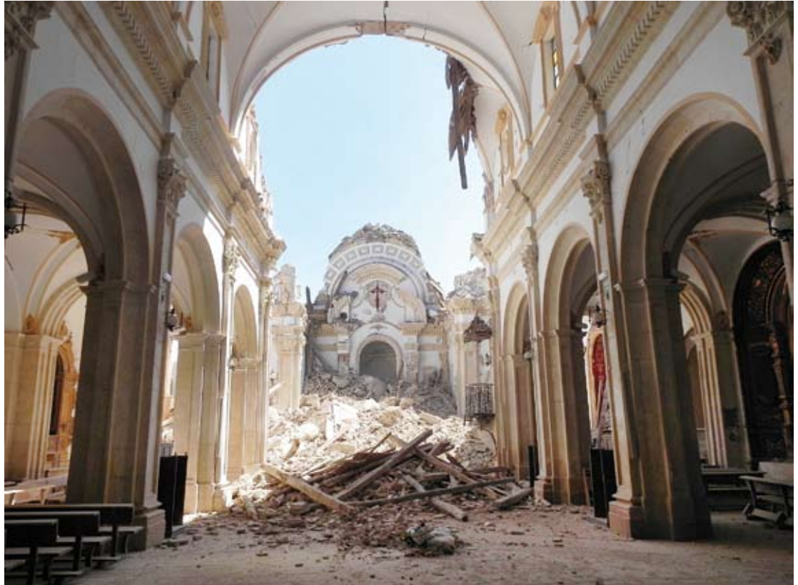
Figura 13. Estado de la Iglesia de Santiago tras el terremoto. Se aprecian los restos aún “colgados” de parte de la losa de hormigón sobre la parte de cubierta del templo que se ha mantenido en pie. Figure 13. The condition of the church of Santiago after the earthquake. The remains hanging from the concrete are visible in the photograph.
