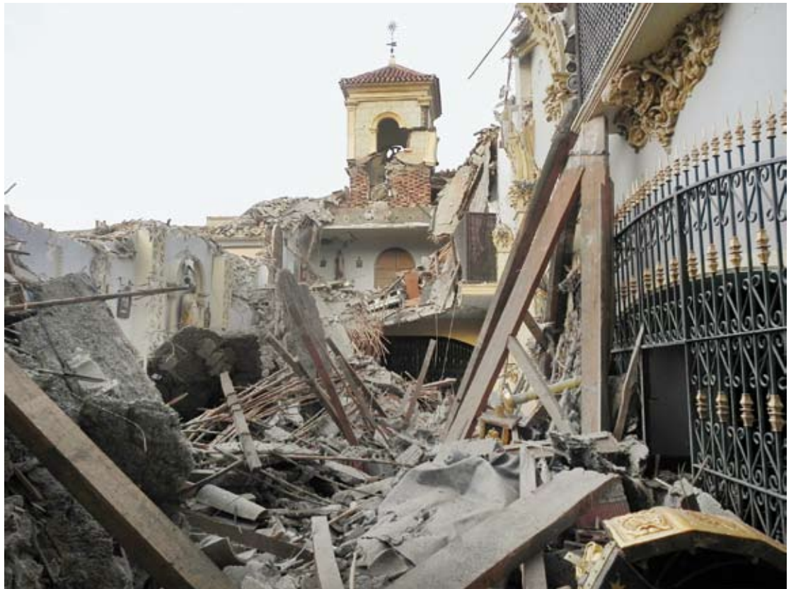
Figura 14. Estado de la Iglesia del Monasterio de Clarisas, tras el terremoto. Los restos de escombros albergan por un lado las cerchas de madera que conformaban la cubrición del Templo y, por otro, la losa de hormigón armado colocada sobre ellas. Figure 14. The condition of the church of Las Clarisas monastery after the earthquake; the remains contain the whole wooden ceiling structure and the reinforced concrete floor above it.
