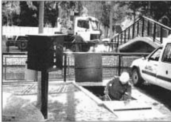
Figura 12. Arqueta de sondeo urbano.
