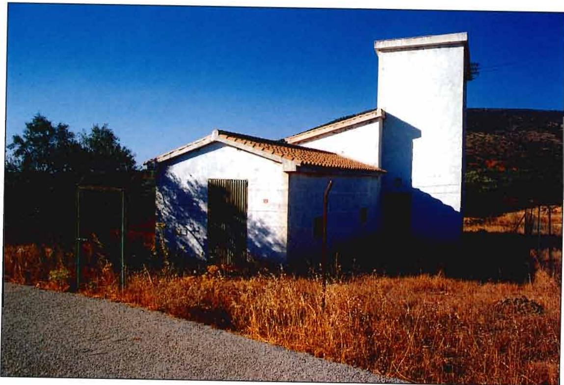
Foto 9.- Sondeo del IARA en la Sierra de Mollina, utilizado actualmente como piezómetro.
