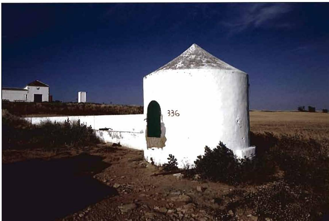
Foto 17.- Uno de los numerosos pozos situados en la cuenca de Fuente de Piedra que es utilizado actualmente como piezómetro.
