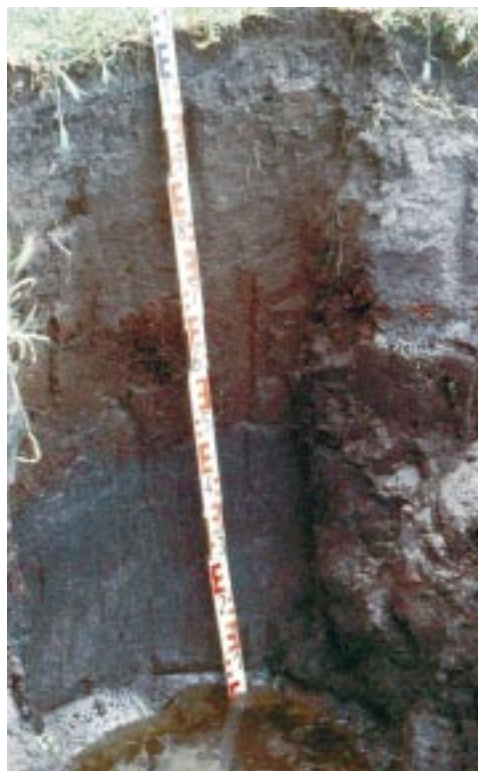
Foto 3.6 Cuando a la escasa profundidad del suelo se une un exceso de permeabilidad es muy difícil garantizar la correcta depuración del vertido, haciendo imposible su empleo en sistemas de depuración natural. En el ejemplo de la foto, el nivel freático está apenas a 90 cm de la superficie, el material son arenas y las condiciones redox reductoras.
