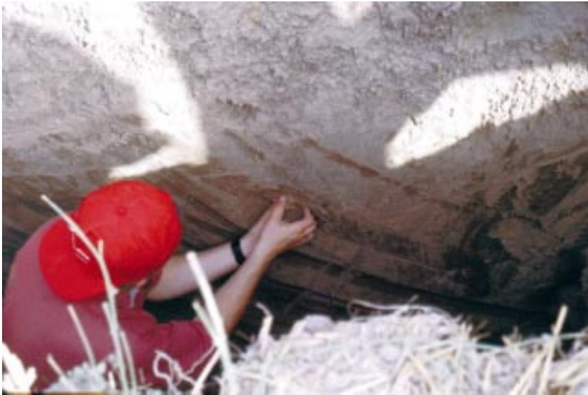
Foto 3.4 La realización de una prospección previa mediante la excavación de catas, con una profundidad mínima de 3 metros, puede ahorrar mucho dinero y esfuerzo. Este trabajo permitirá descubrir la presencia de discontinuidades geológicas o hidrogeológicas, no visibles en superficie y que pueden afectar muy negativamente al funcionamiento del sistema de IR.
