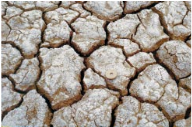
Foto 7.10 Aspecto de la superficie del lecho filtrante, antes, inmediatamente después y 21 días tras el vertido del agua residual. Las algas que crecen en las primeras etapas de desecado son completamente mineralizadas al final.
