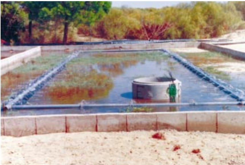
Foto 7.11 Vista de una de las balsas de infiltración en pleno funcionamiento.
