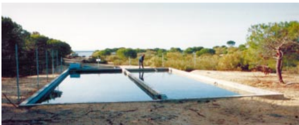
Foto 7.12 Vista de las balsas de decantación.
