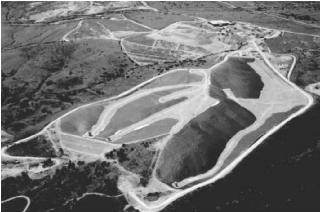
Figura 1. Vista aérea de las vaguadas que constituyen el vaso de vertido de la fase III durante su construcción.
